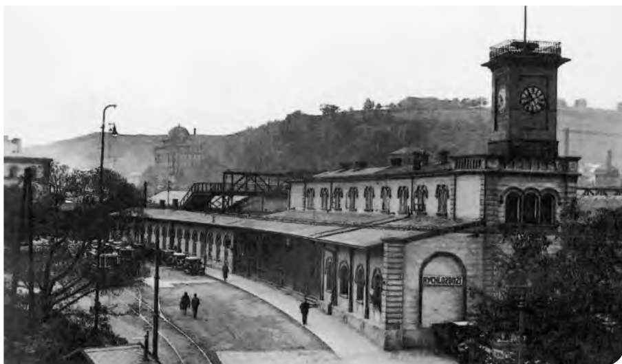
Původní příjezdová budova České západní dráhy na Smíchově
