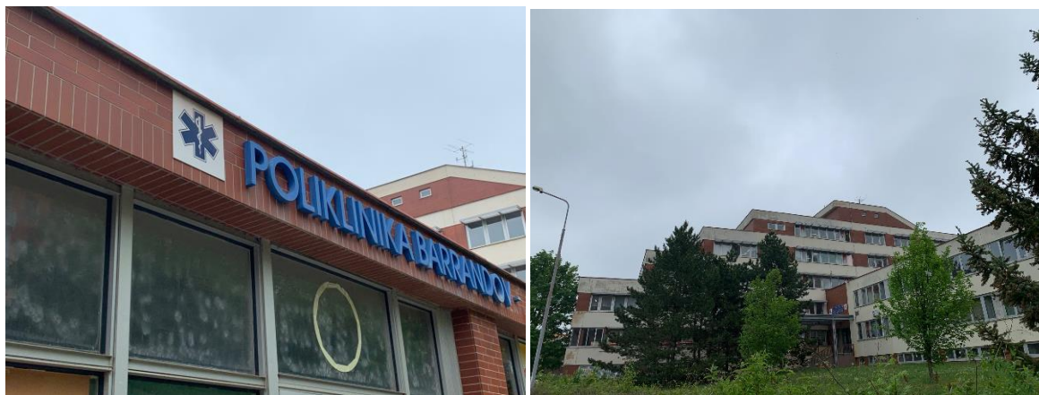
Stav před zahájením projektu
