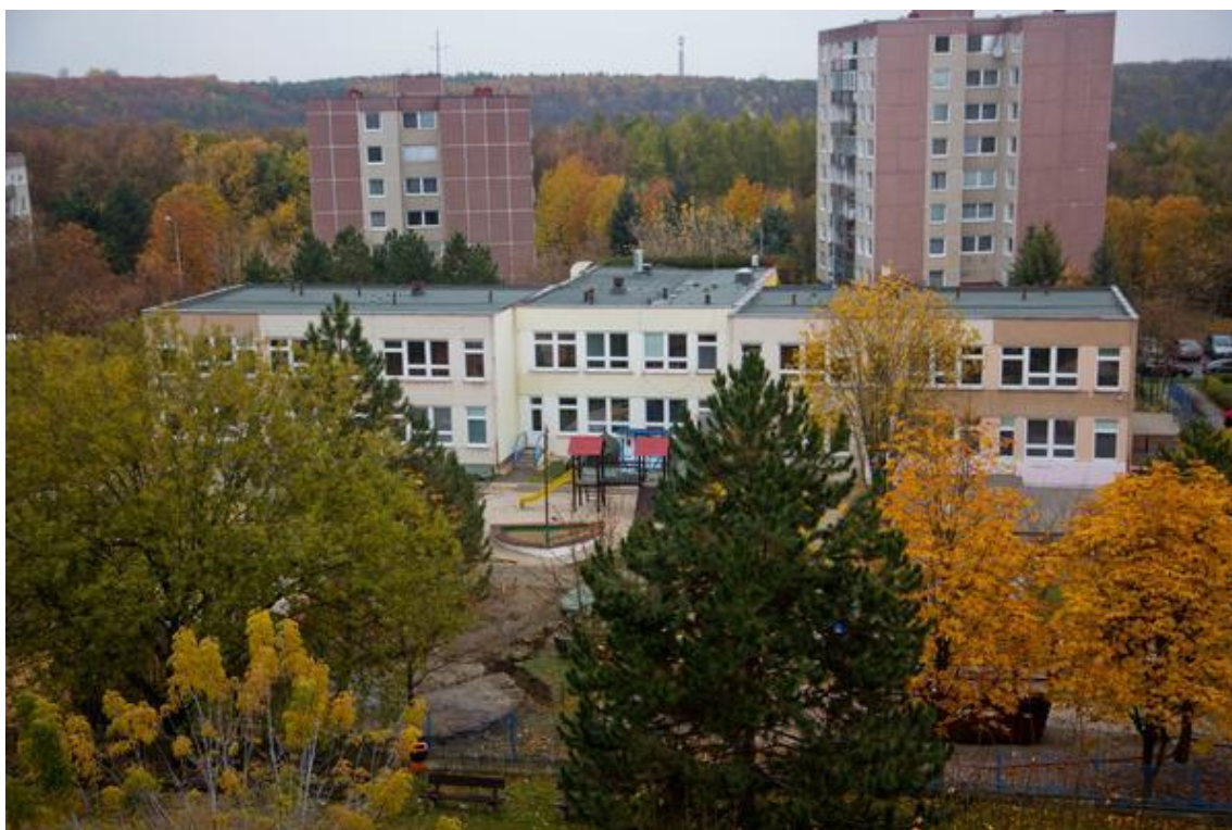
Stav MŠ Lohniského č.p. 830 před realizací projektu.
