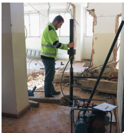
Po rekonstrukci se do objektu vrátí školní provoz
