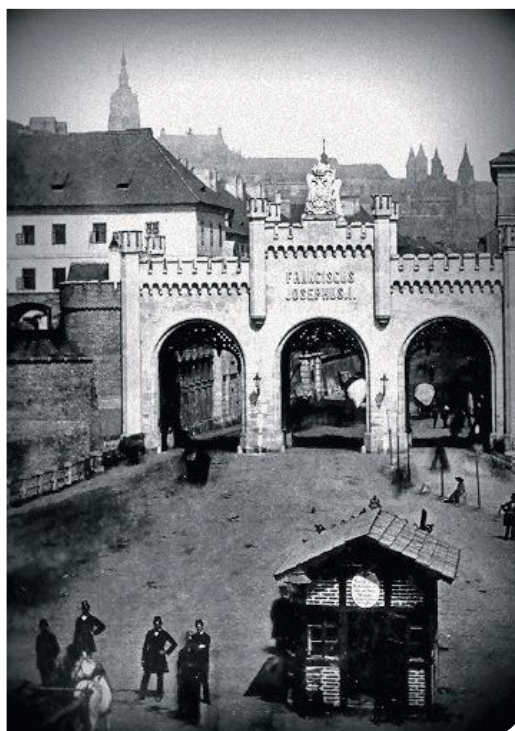
V popředí snímku je přístřešek strážce, která vybírala potravinovou daň
